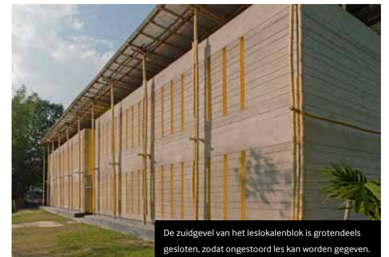
Leslokalen zijn aan de zuidkant voorzien van hoge verticale raamopeningen en aan de koele binnenhofzijde van kleine vierkante ventilatieopeningen, waardoor trek ontstaat.
